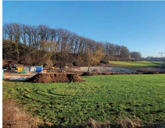
Bau eines Regenrückhaltebeckens zwischen den Ortsteilen Buttendorf und Neuses, Foto: Hamperl
