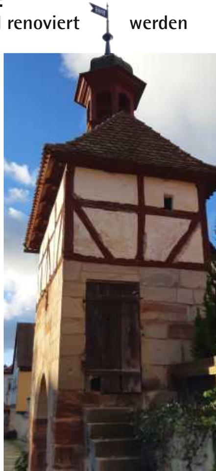
Schäden an Mauerwerk und Gebälk des Tortürmchens sind deutlich erkennbar
